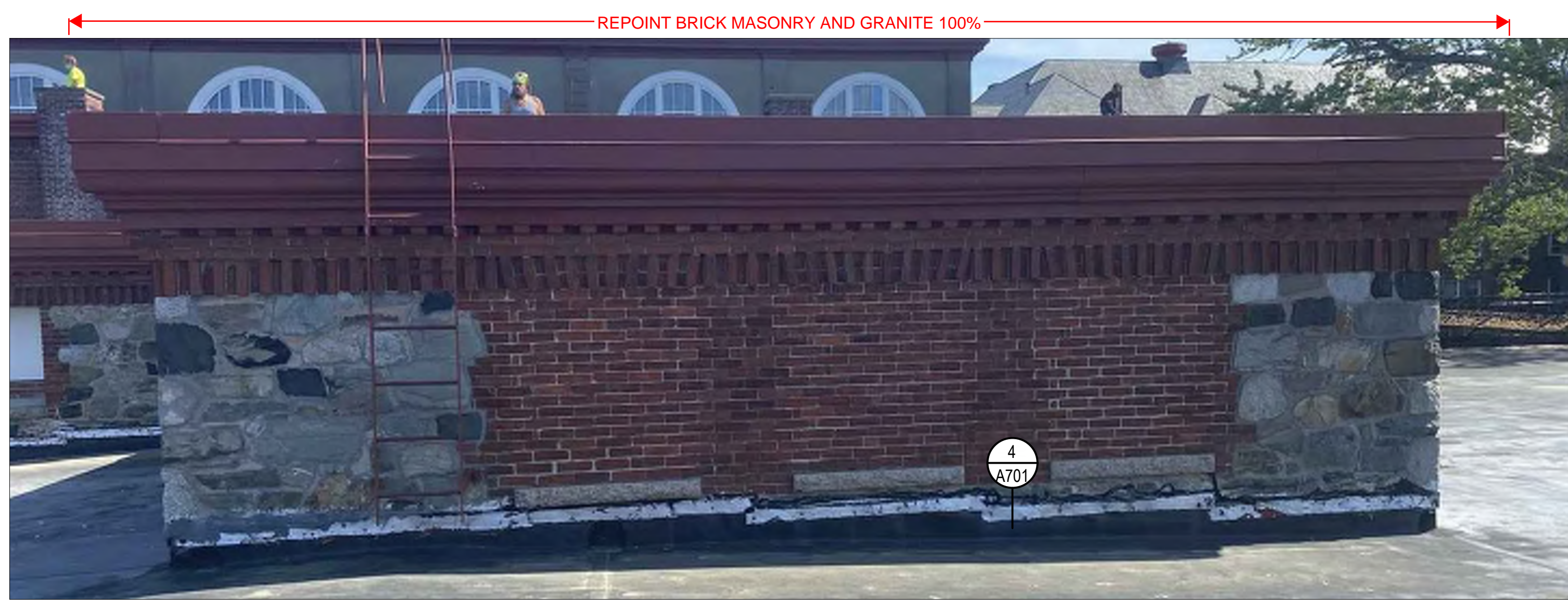
3 ROOF AREA F RISING WALL ELEVATION SCALE: N.T.S.
